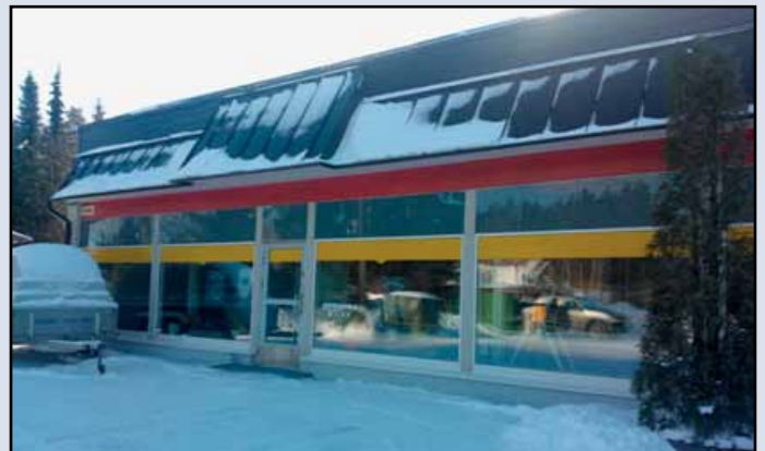
Julkisivu odottaa kesää jotta saadaan ikkunateippaukset tehtyä.
